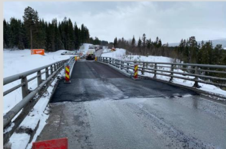
Stavåbrua m/ reservebru med ramper sentrikk over deler av bruas utfordringer. Dette fordeler kreftene og avlaster konstruksjonen til Stavåbrua. (Foto: Peter Husby)
